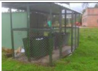
Módulo Vereda Las Auras
