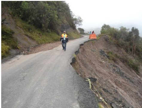
Áreas de deslizamiento en vías locales Recorridos Comité Local Ambiental Sumapaz 2012
