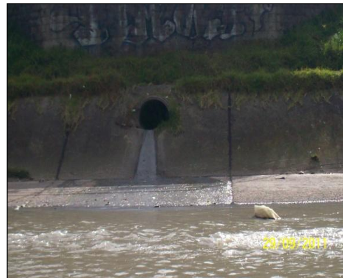
Carrera 51 con diagonal 16 sur. Costado Sur
