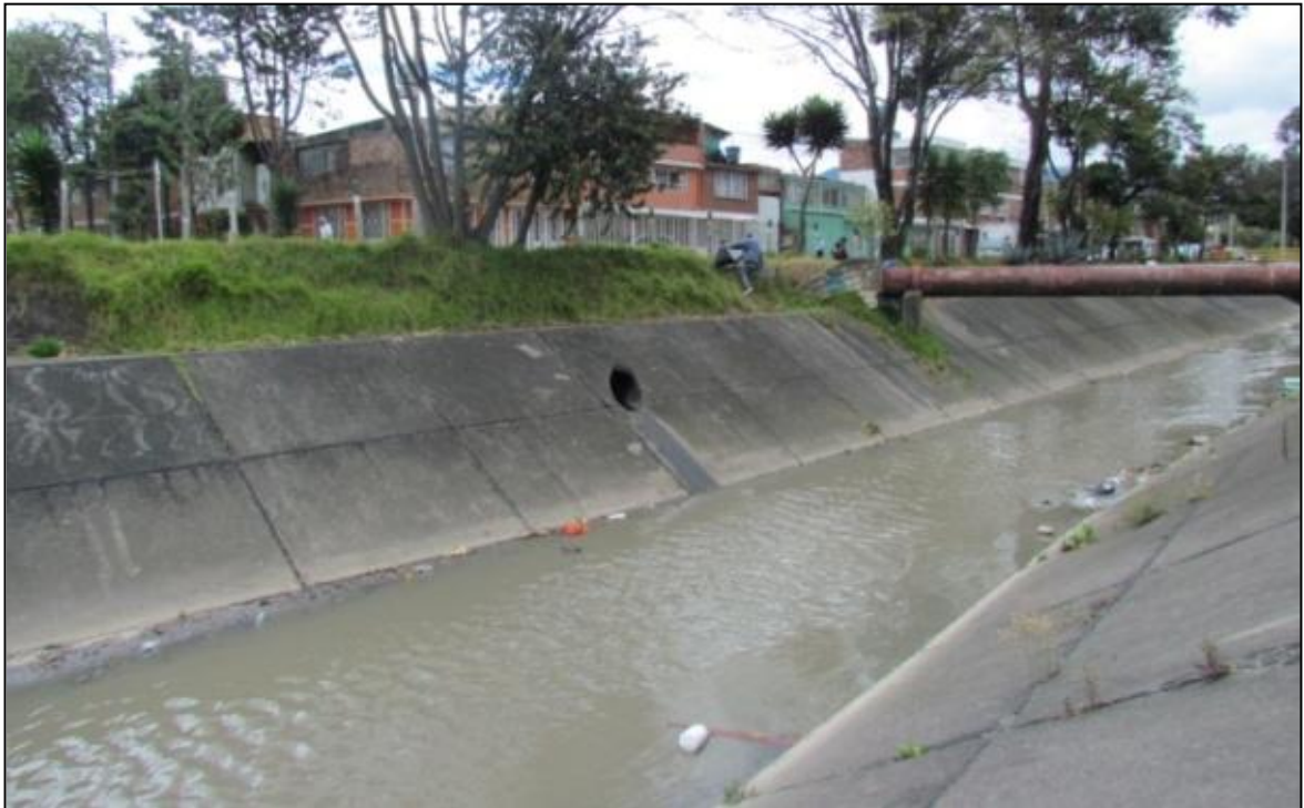
Calle 29-A Sur No. 35-95 – Vertimiento Industriales
