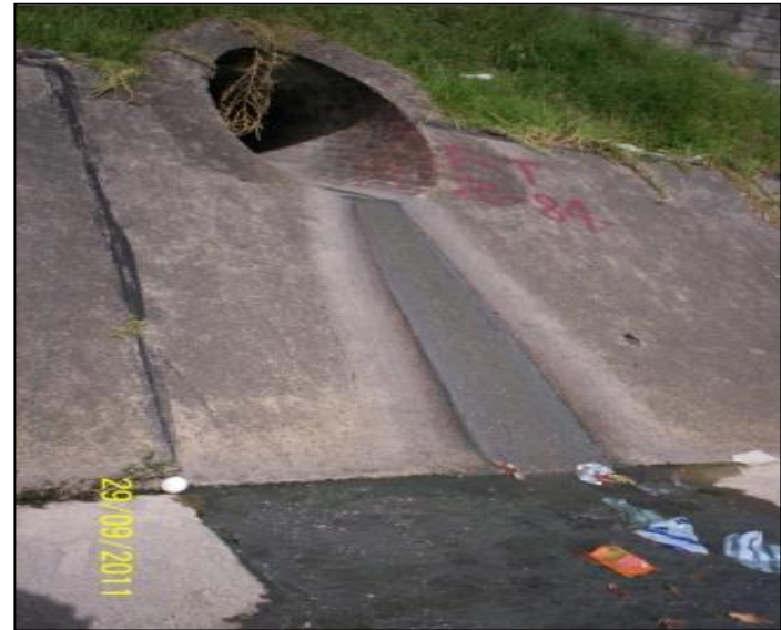
Carrera 41 A con diagonal 16 sur. Costado Norte
