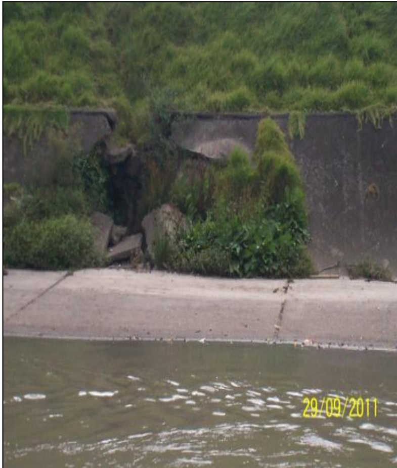
Canal Río Fucha con Calle 8 sur. Bajante al canal
