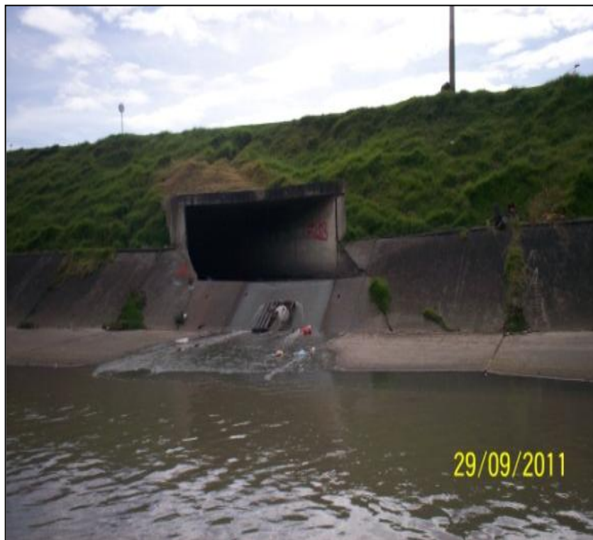
Canal Río Fucha con Transversal 60. Costado sur
