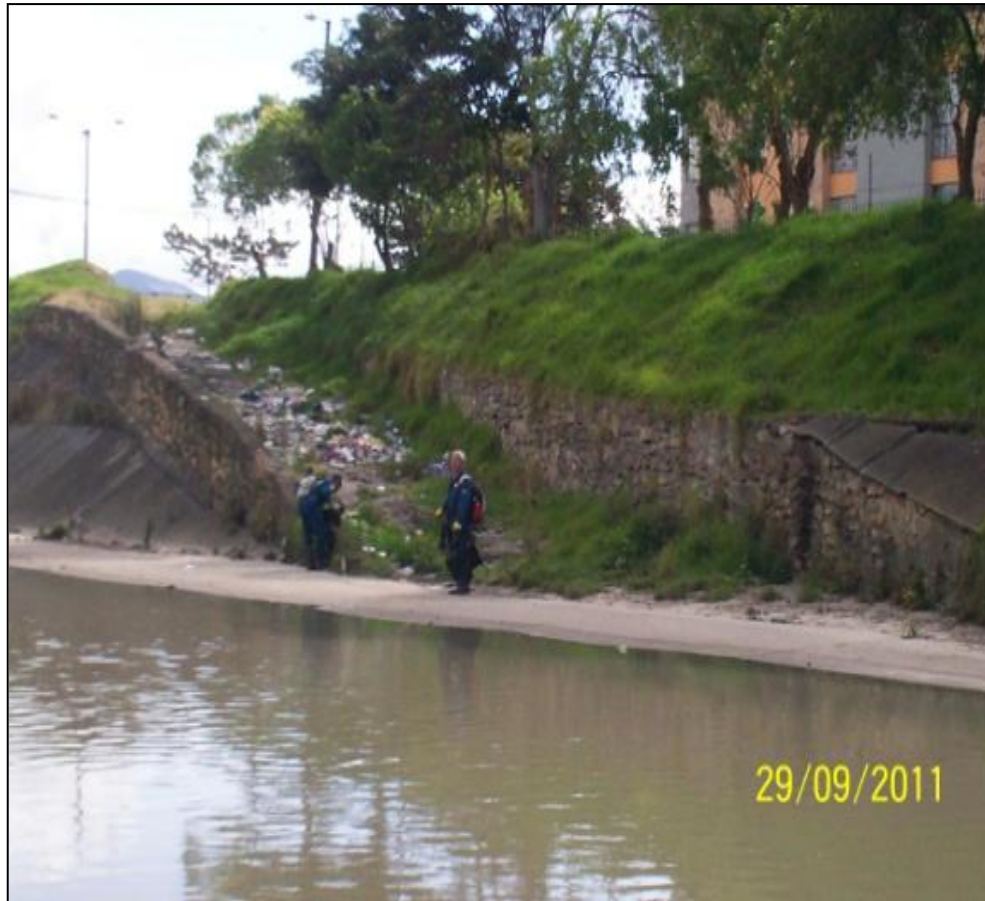
Canal Río Fucha con Calle 8 sur. Bajante al canal
