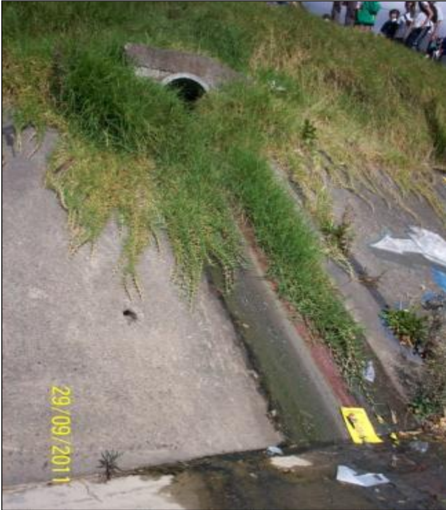
Carrera 50 con diagonal 16 sur. Costado sur
