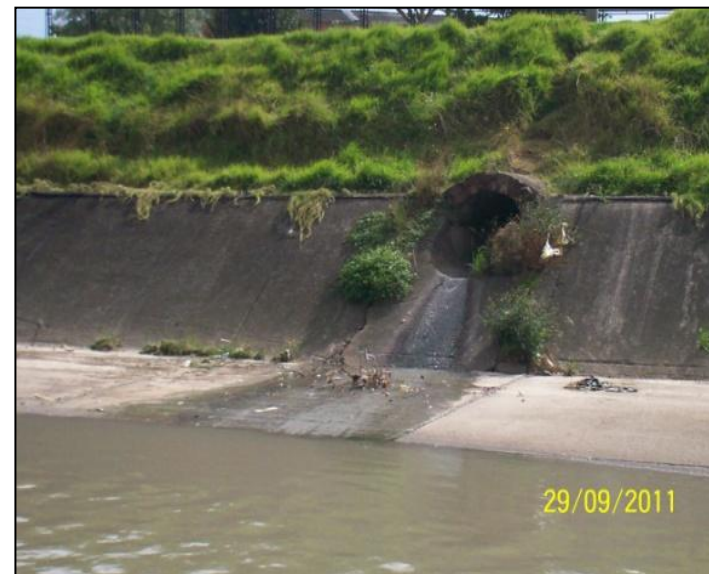
Canal Río Fucha con Transversal 53ª. Costado Sur
