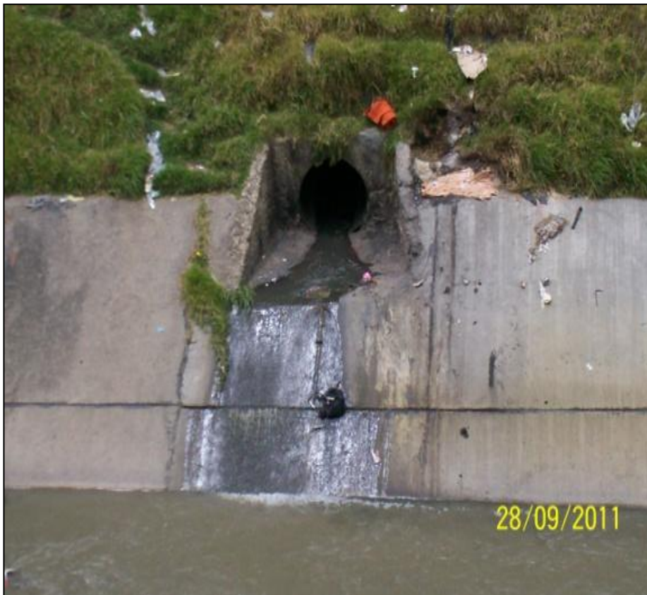
Avenida 6 con Carera 34 Costados sur
