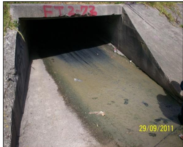
Carrera 41 A con diagonal 16 sur. Costado Norte
