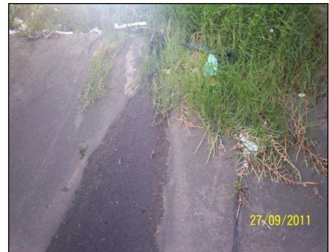
Separador carrera 50, costado sur
