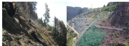
Sendero peatonal al Santuario de Monserrate. Fuente: Instituto Distrital de Gestión de Riesgos y Cambio Climático - IDIGER
